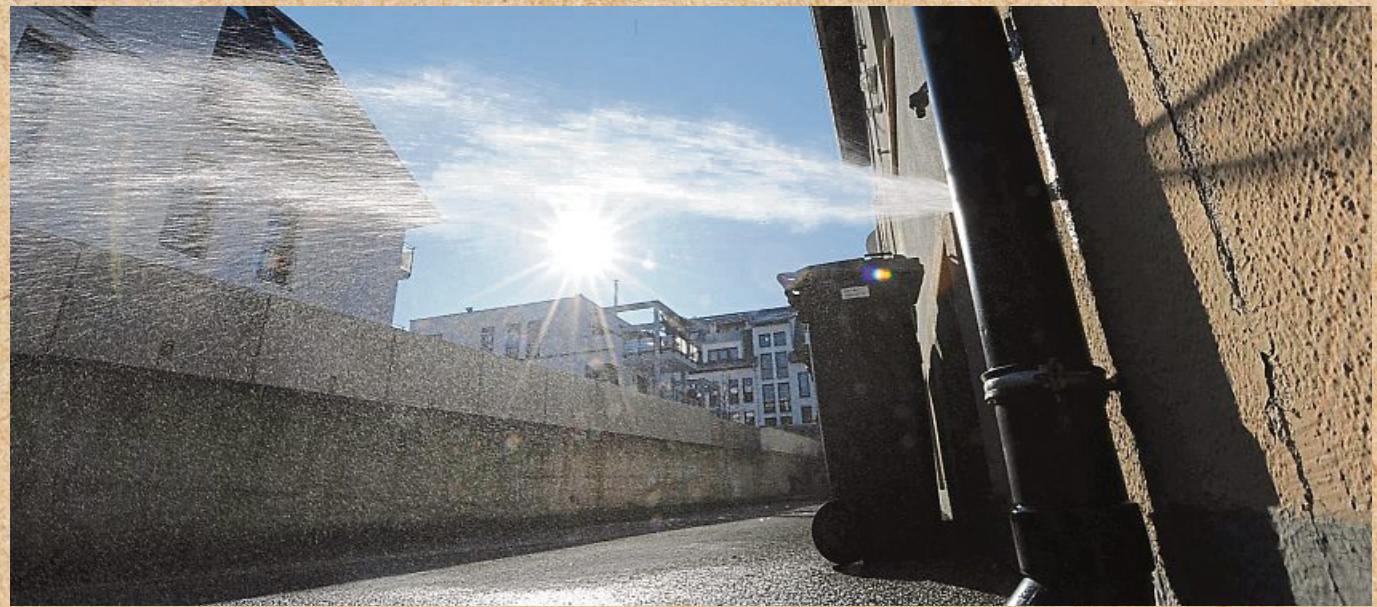
Ein Rohrbruch kann vor allem im Winter großen Schaden anrichten.
