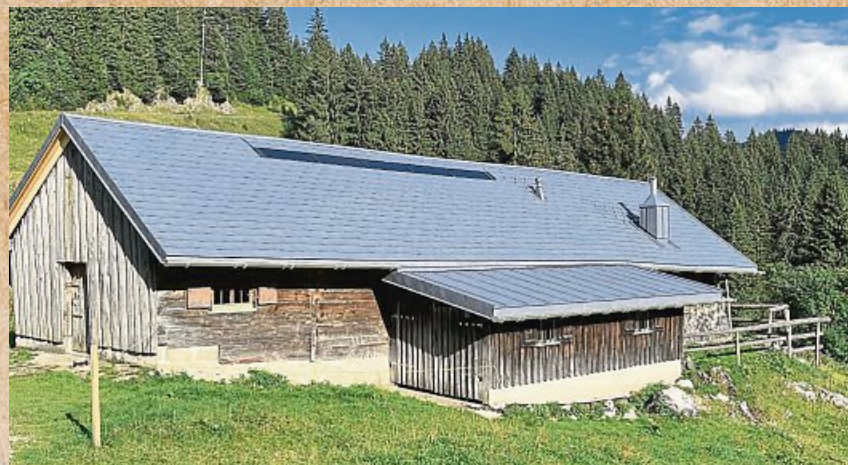
Hoch gelegene Baustelle: Die Amperthal-Alm in der Nähe des Schönbergs.
