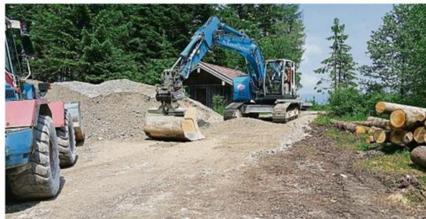
Bauarbeiten am Leiterberg: Hier wird ein neuer Forstweg angelegt, der 45 Hektar erschließt.
