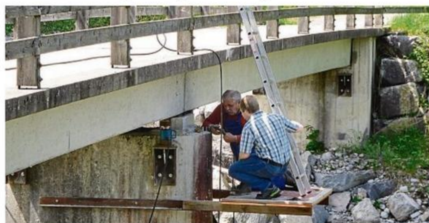
Arbeiten am Mittelpfeiler am eigens errichteten Gerüst am Jachensteg.
