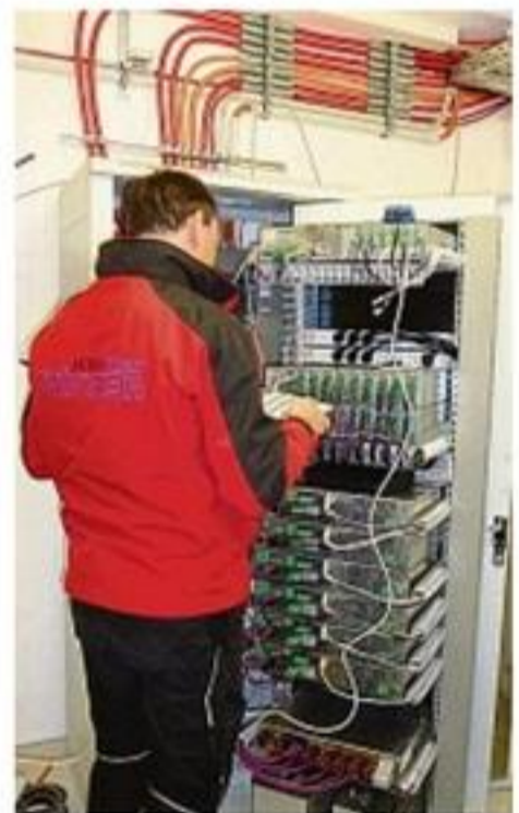
Kabel über Kabel: Ein Monteur schließt die neue Lautsprecheranlage an.
