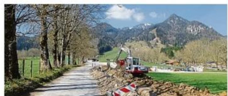
Grabungsarbeiten: Entlang der Zufahrt zum Draxlhang wird die neue Wasserleitung fürs Brauneck verlegt.
