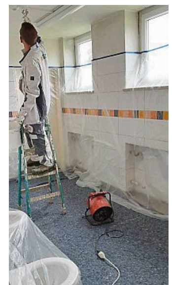
Malerarbeiten in einem WC der Lenggrieser Schule.
