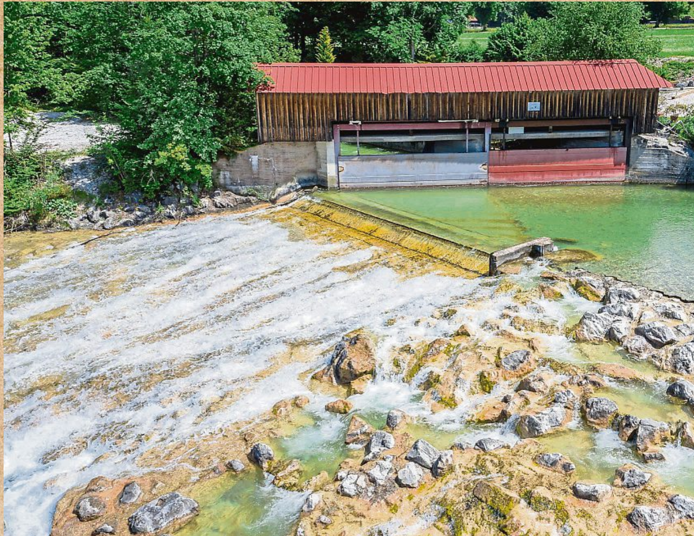
Am Wehr in Fleck wird Wasser aus der Isar ausgeleitet, um damit Strom zu erzeugen.
