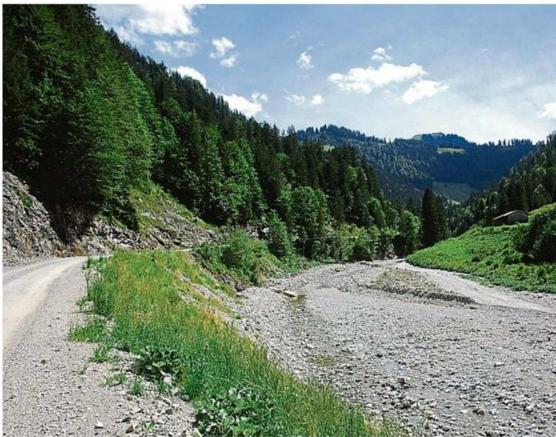
Die Dürrach im Bächental ist vor allem im Sommer weitgehend ausgetrocknet. Das soll sich ändern.
