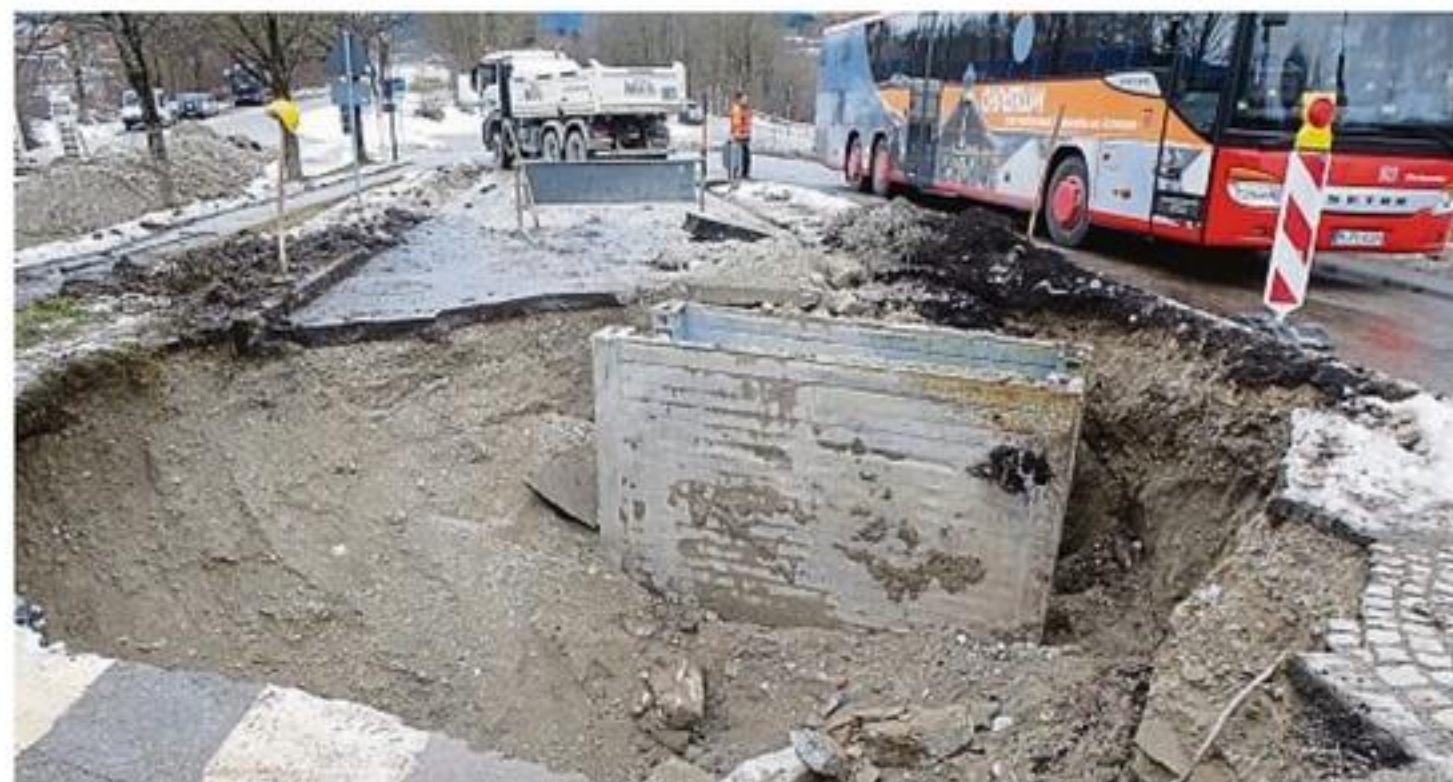
Tiefbaustelle: Das Reparaturloch an der Zufahrt zur Bundesstraße 13.
