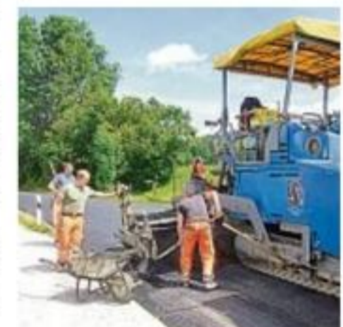
Einbau der Tragdeckschicht in der Sylvensteinstraße.
