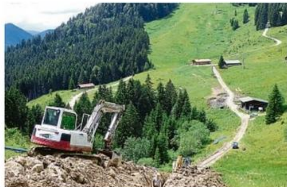
Baustelle am Berg: Grabarbeiten von der Florihütte hinunter in den Finstermünzkessel.
