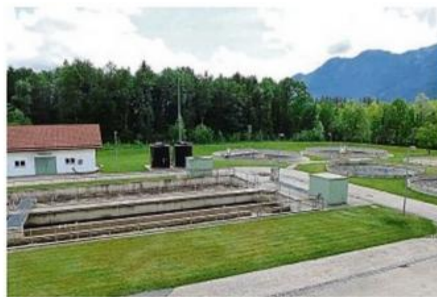
Die Lenggrieser Kläranlage soll ausgebaut werden.
