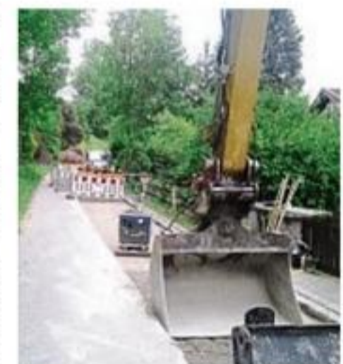
Die neue Leitungstrasse wird asphaltiert.
