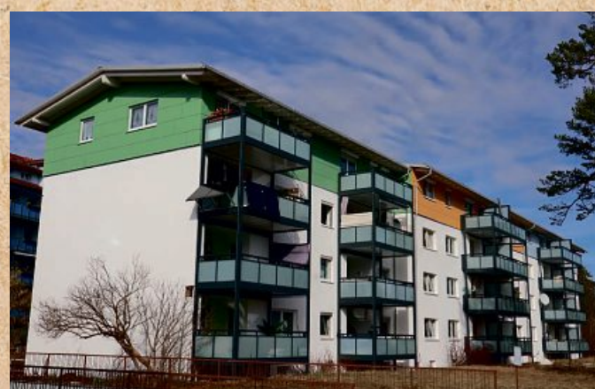
Aufgestockt: Reihenhäuser in Lenggries.
