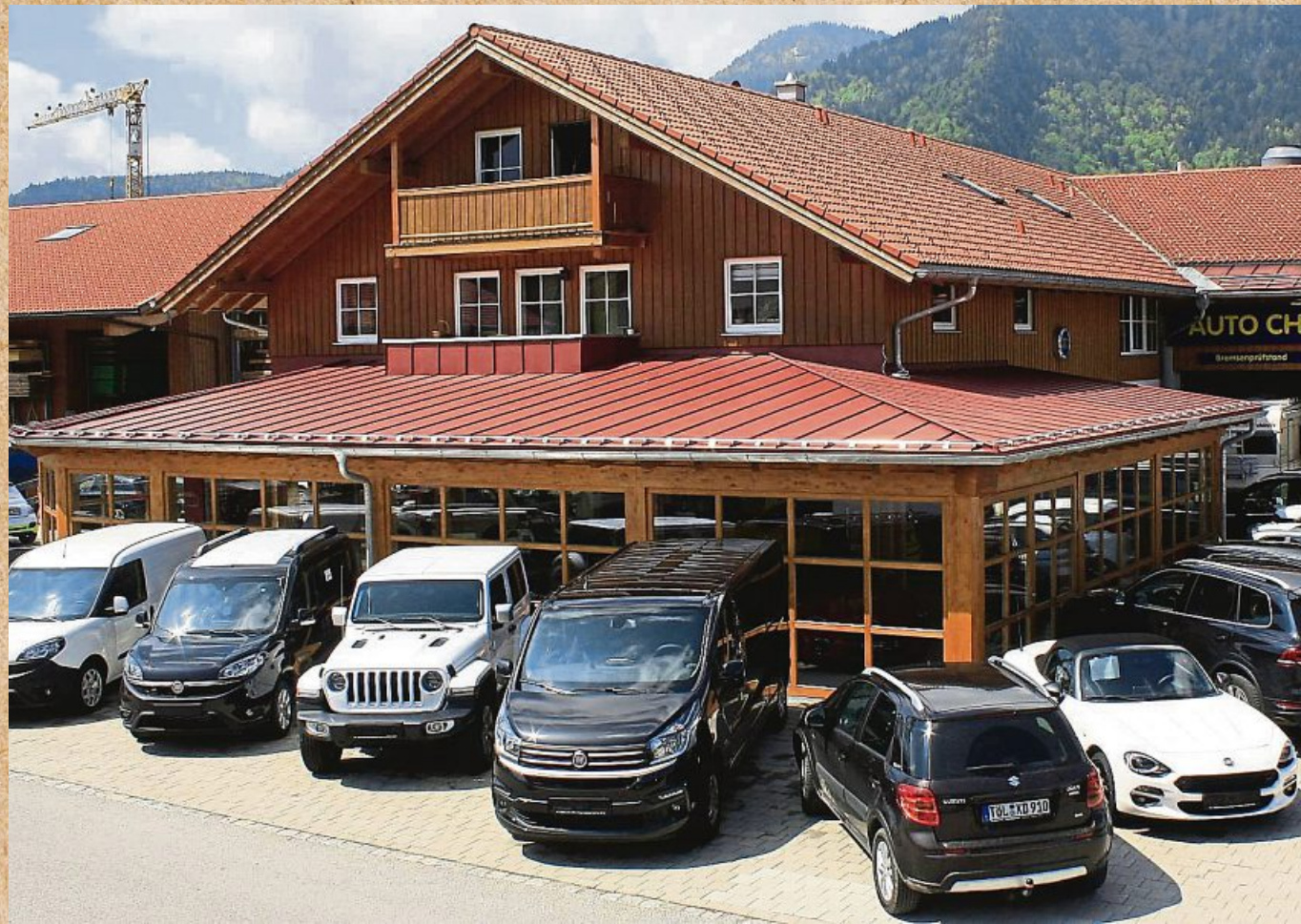
Das Autozentrum Isarring bietet einen umfangreichen Service an.
