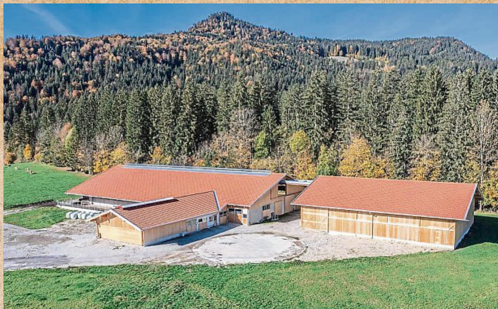
Großprojekt: In dem dreiteiligen Gebäudekomplex mit Milchviehlaufstall, Kälberstall und Bergehalle mit Heutrocknung wurden 550 Kubikmeter Holz verbaut.
