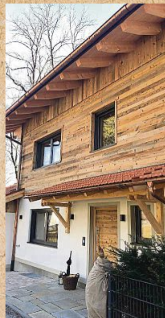
Traditioneller Blockbau an einem Neubau.
