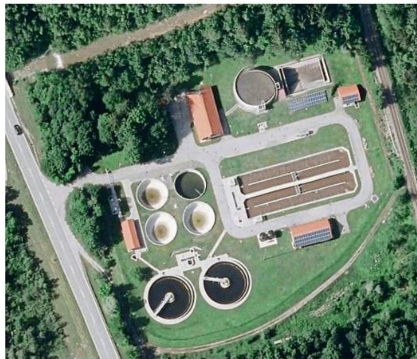
Die Kläranlage aus der Vogelperspektive: In das runde Becken in der oberen Bildhälfte sollen der Faulbehälter für den Schlamm sowie das Blockheizkraftwerk eingebaut werden. Die Straße am linken Bildrand ist die B 13. Am rechten Bildrand sieht man die Bahnlinie.
