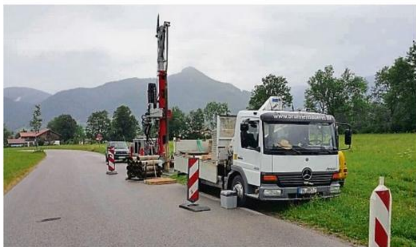
Erkundungsbohrungen neben der Zufahrtsstraße zur Bergbahn-Talstation.
