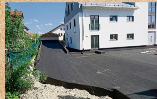
Abdichtung einer Parkplatz-Auffahrt.
