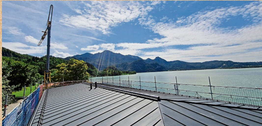
Hoch über dem See: eine Großbaustelle der Firma Reiser.
