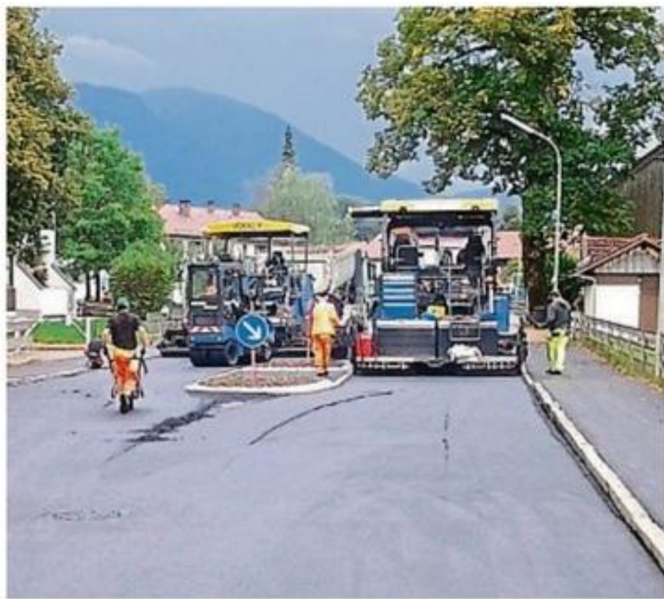
Die Deckschicht wird in der Wackerberger Straße aufgetragen.
