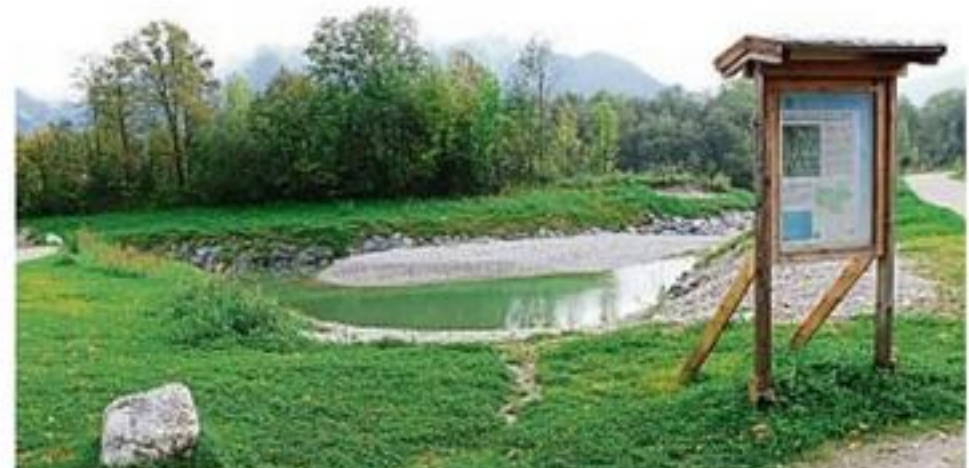
Einmündung: Am neuen Isarseitenarm soll eines Tages das Hochwasser des Lahnerbach-Überlaufs abfließen. FOTO: AO
