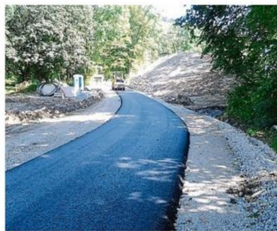
Die frisch asphaltierte Straße führt am Hochbehälter vorbei.
