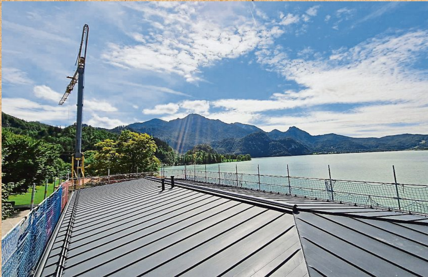
Hoch überm See: Eine Großbaustelle der Firma Reiser.
