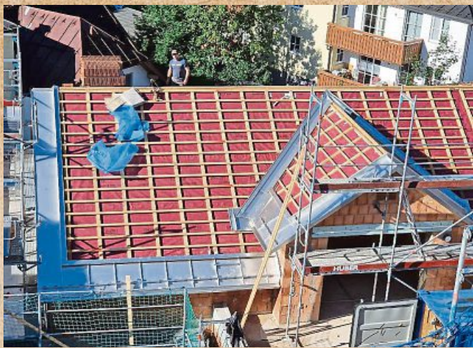
Über den Dächern ist der Arbeitsplatz der Spenglerei.
