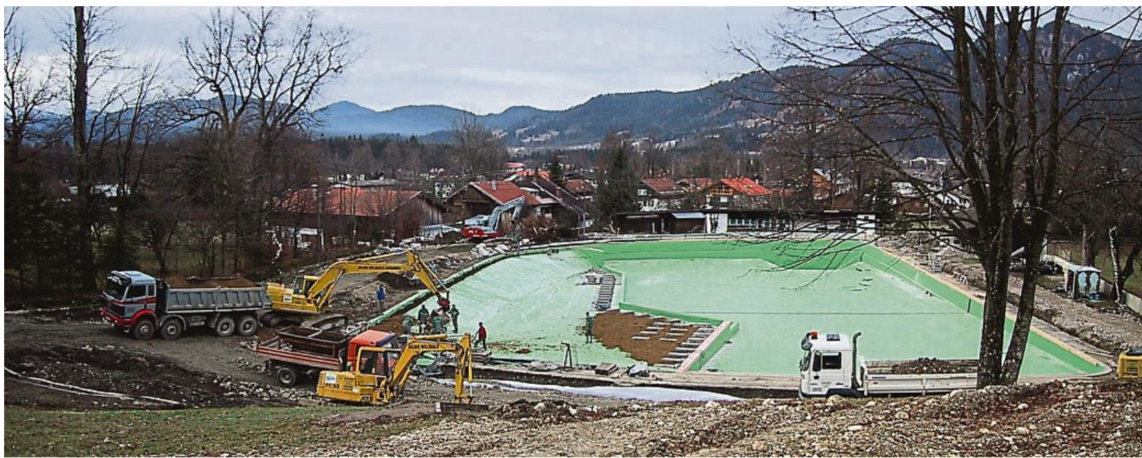
Der Umbau: Aus dem Lenggrieser Schwimmbad wird im Winter 2000/2001 ein Naturbad mit großer Regenerationszone.
