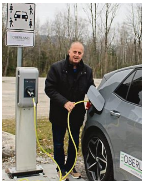
An der Ladestation am Isarparkplatz. 20
