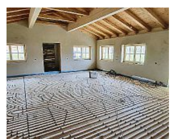
Fußbodenheizung fürs Stüberl.
