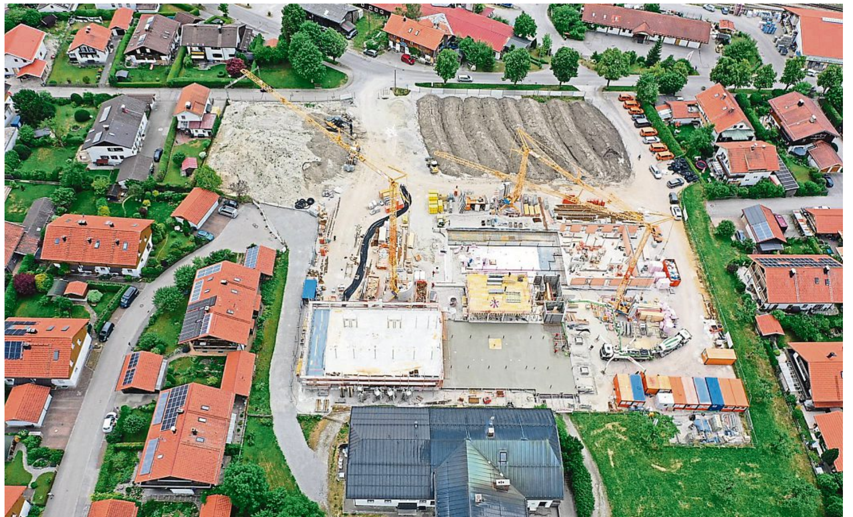
Großbaustelle zwischen Demmeljochstraße und Karwendelstraße: Hier baut die Gemeinde Lenggries das neue Pflegeheim.
